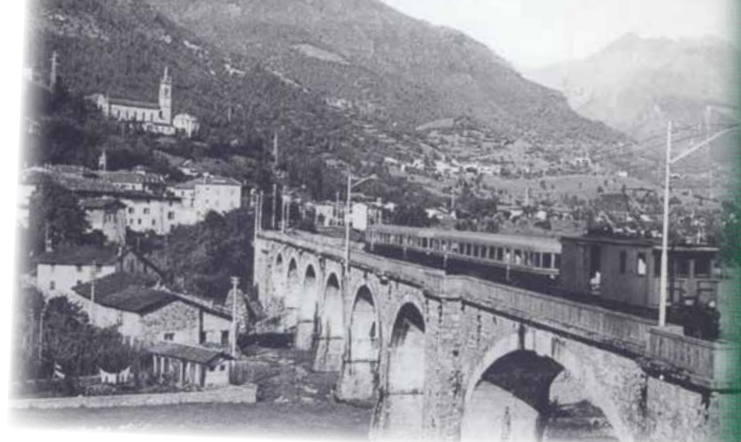
Il treno sul ponte di Lenna in una foto degli anni '60. (Collezione privata)
